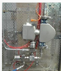
Misuratore Coriolis
